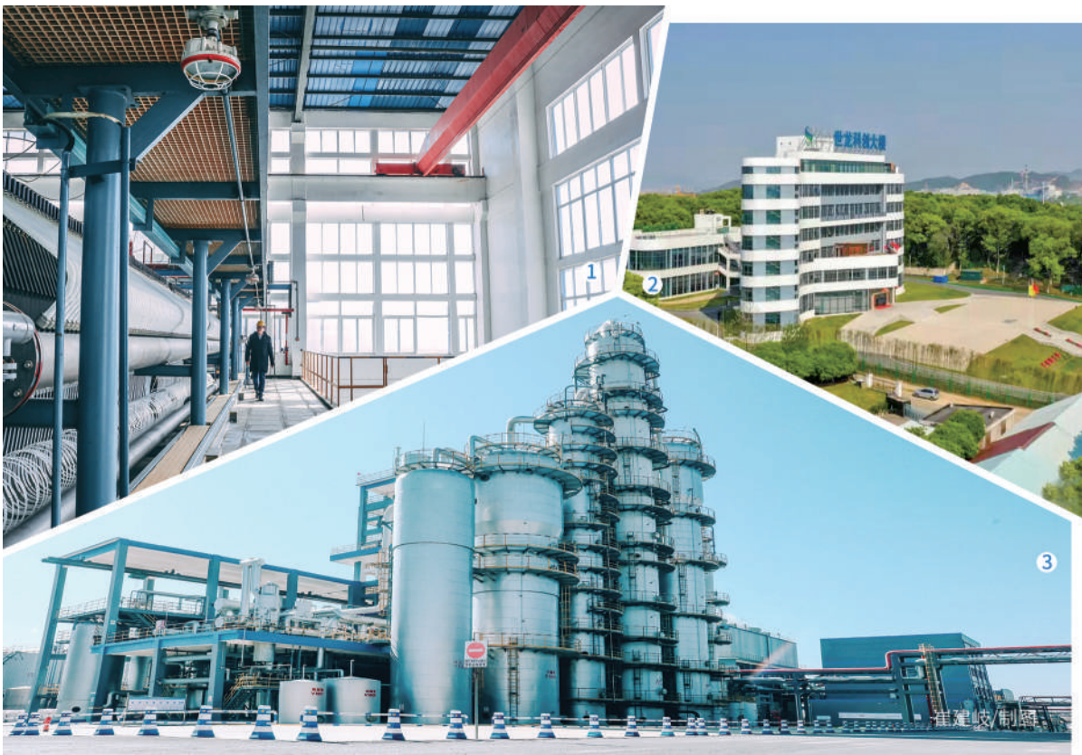
图①世龙实业离子膜烧碱生产车间
