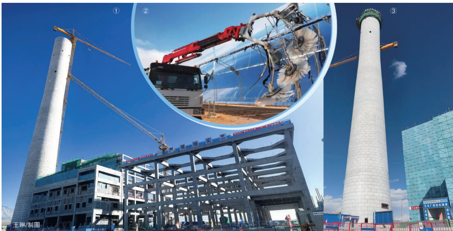
图①中广核德令哈200万千瓦光热储一体化项目建设现场
