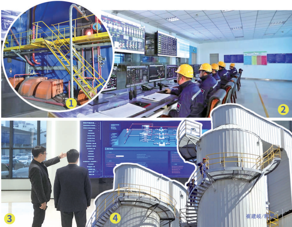
图①浑南热力热源厂供暖锅炉 图③联美控股智慧运营平台
