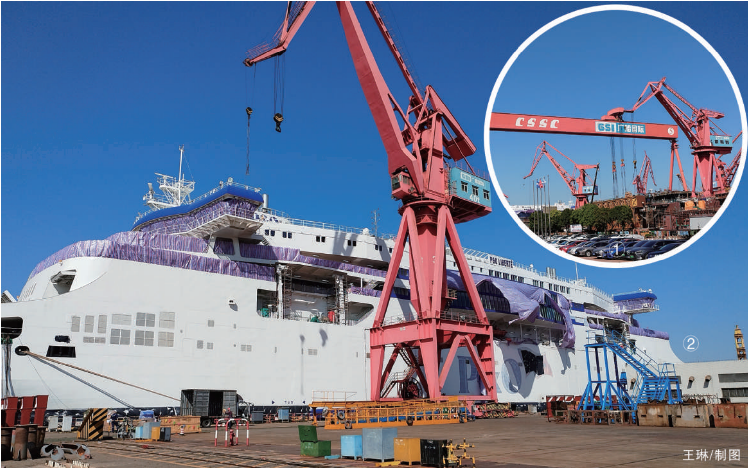
图①广船国际中心段作业区,机器满负荷运作中
