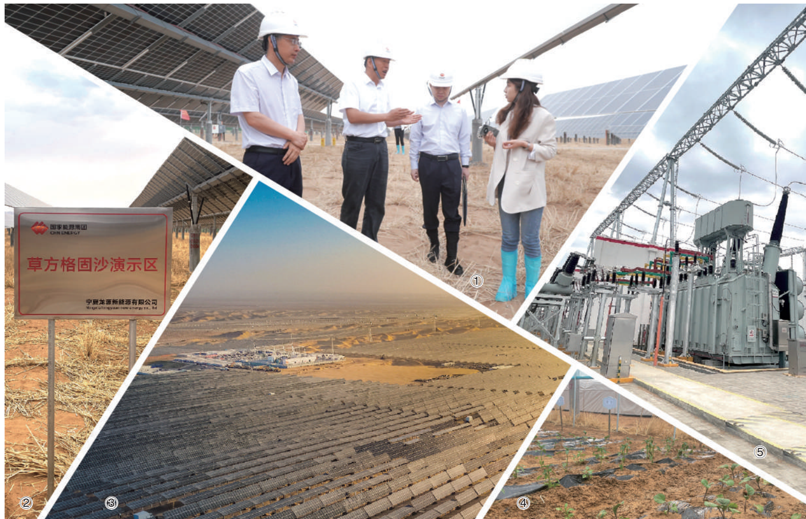
图①为龙源电力宁夏公司相关负责人向《证券日报》记者介绍一期项目（供图：龙源电力）/图②为一期项目草方格固沙示范区（摄影：马宇薇）/图③为宁夏腾格里沙漠新能源项目基地（供图：龙源电力）/图④为一期项目基地实验性蔬菜大棚（摄影：马宇薇）/图⑤为一期项目330kV升压站（摄影：马宇薇）
