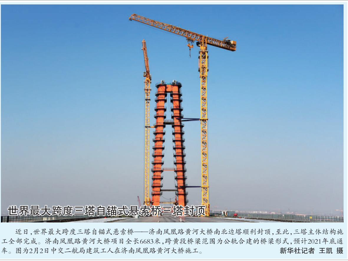
近日，世界最大跨度三塔自锚式悬索桥——济南凤凰路黄河大桥南北边塔顺利封顶，至此，三塔主体结构施工全部完成。济南凤凰路黄河大桥项目全长6683米，跨黄设桥梁范围为公轨合建的桥梁形式，预计2021年底通车。图为2月2日中交二航局建筑工人在济南凤凰路黄河大桥施工。
